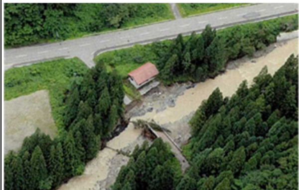
林道の路体流出（米沢市八谷沢線）
