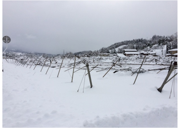
② ぶどう棚倒壊（山形市） 平成 29 年 1 月 16 日撮影
