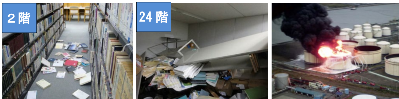
図2 （左・中）東京都内の同じビル内での被害の違い（工学院大学提供） （右）苫小牧の石油タンクの被害（総務省消防庁 消防研究センター提供）
