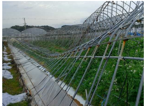
写真②倒壊したパイプハウス
