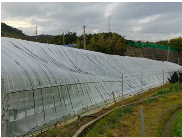
写真⑤変形したパイプハウス
