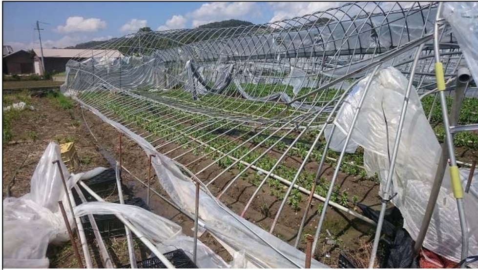
倒壊したパイプハウス（紀の川市）
