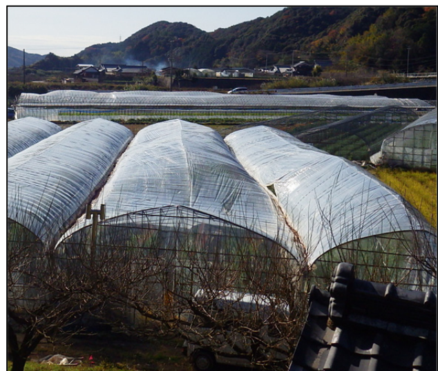
⑫ 鋼管の変形したパイプハウス
