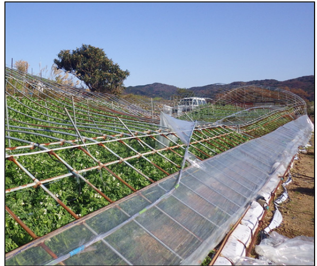
② 倒壊したパイプハウス
