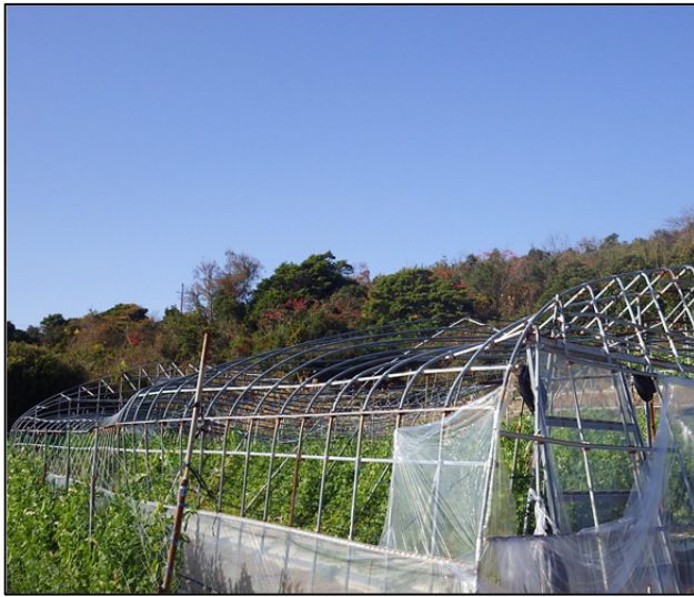
① 倒壊したパイプハウス
