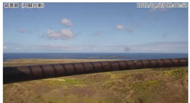
井戸ヶ浜の状況（4月23日撮影）
