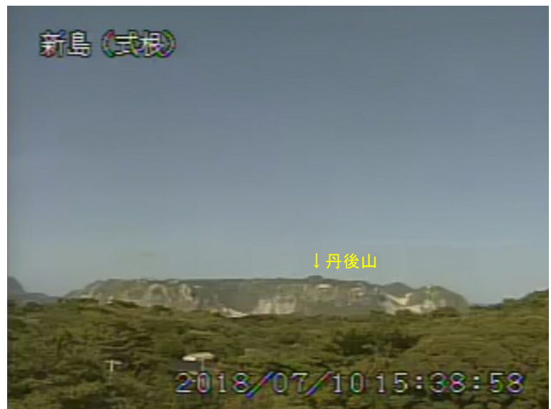
図 2 新島 丹後山山頂部の状況 （7 月 10 日、式根監視カメラによる）
