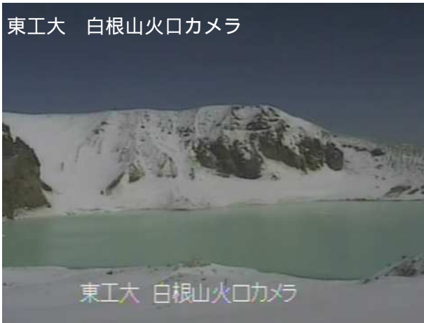
図1 草津白根山 湯釜付近の状況
