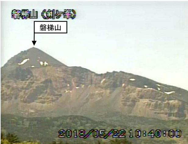
図 1 磐梯山 山体北側火口壁の噴気の状態 （5 月 22 日） ・ 剣ヶ峰（山頂の北約 7 km）に設置している監視カメラの映像です。
