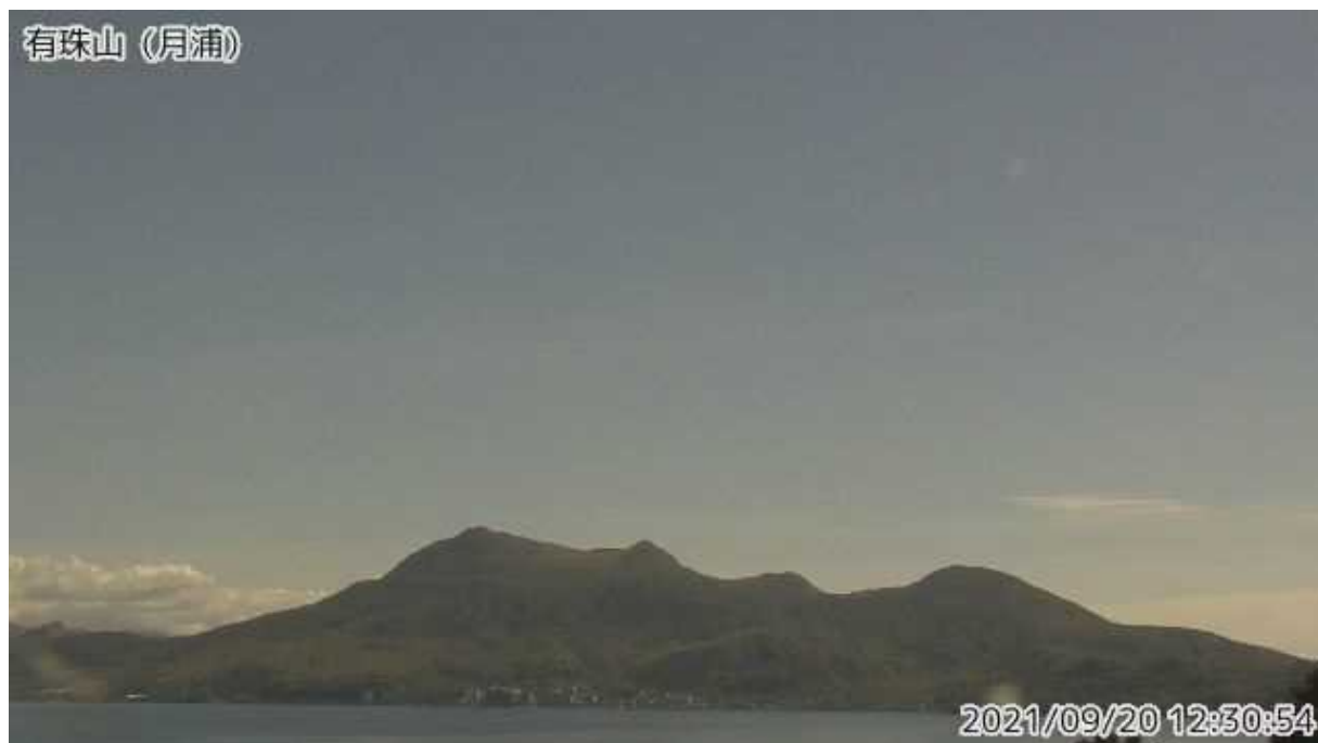
図8 有珠山 北西側から見た山体の状況（月浦監視カメラによる）
