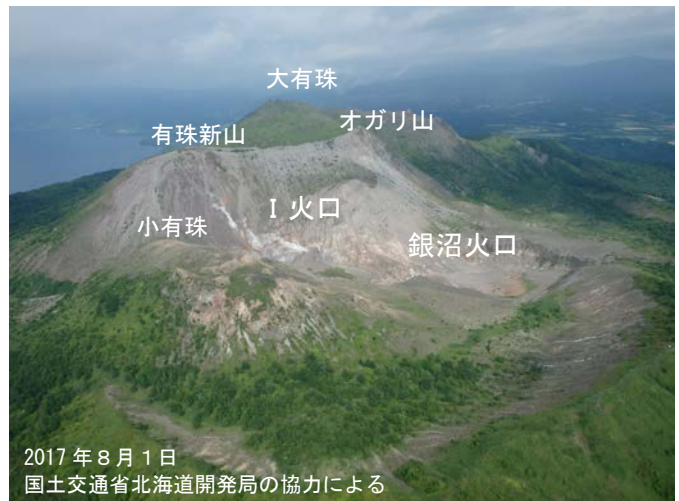
図 3 有珠山 山頂火口原周辺の状況 西側上空（図 2 の①）から撮影
