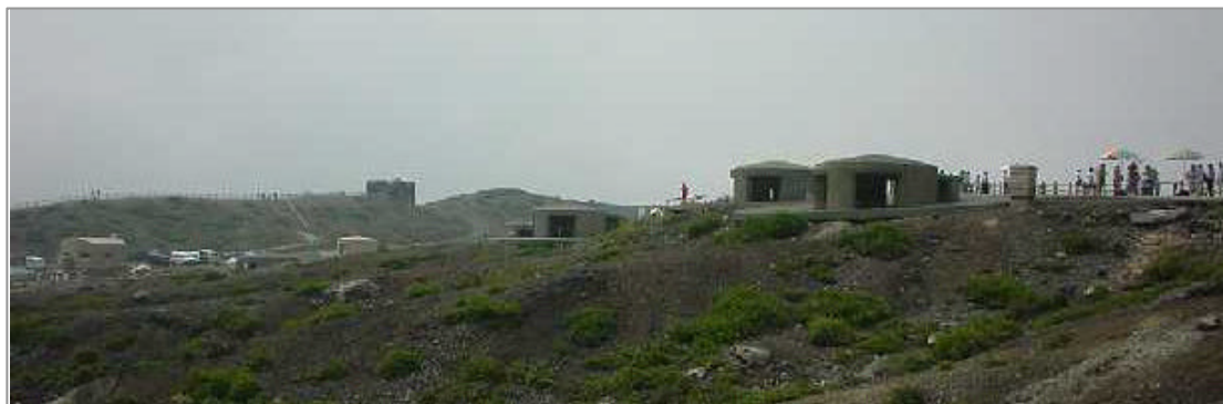
阿蘇山中岳の火口周辺に設置している避難用シェルター
