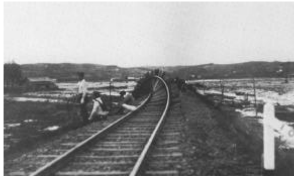
十勝岳の大正泥流で被害を受けた富良野線
