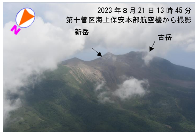
図 5 口永良部島 新岳火口及び古岳火口周辺の状況
