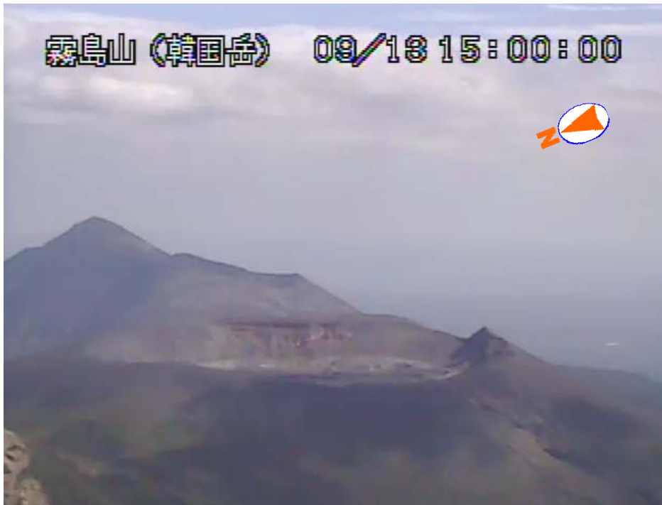
図 1 霧島山（新燃岳） 噴煙の状況（9月13日、韓国岳遠望カメラによる）
