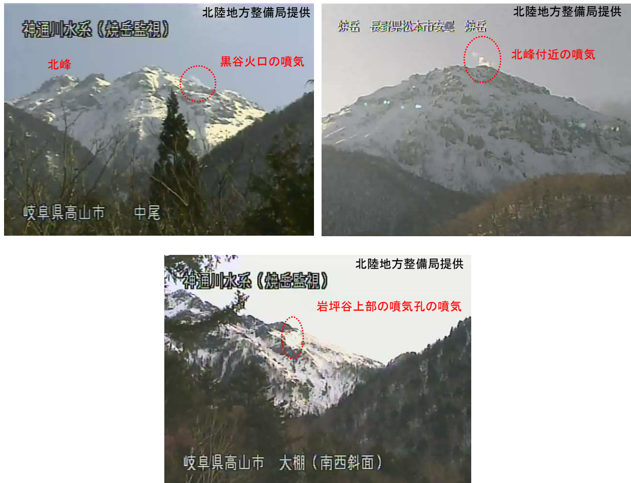
図5 焼岳 山頂部及び南西斜面の状況 （上左図：2月24日 焼岳北監視カメラ、上右図：2月21日 焼岳東監視カメラ、 下図：2月15日 焼岳南西斜面監視カメラ） ・噴気活動に特段の変化はありません。
