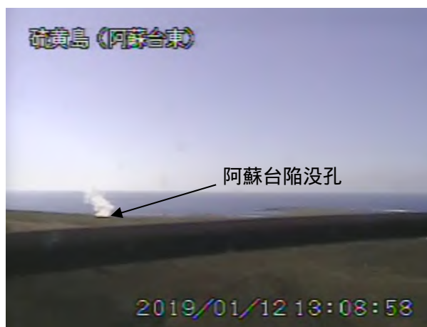
阿蘇台陥没孔の噴気の状況（1 月 12 日撮影）
