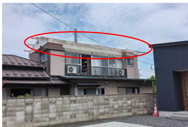
⑤ 屋根の小屋組が飛散した住家 (南方向から撮影)
