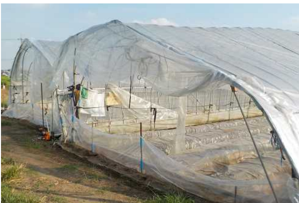
⑤ 変形したパイプハウス (北方向から撮影)
