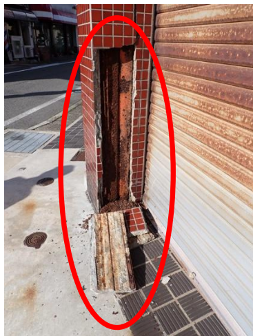
写真 1 外壁の剥離、落下
