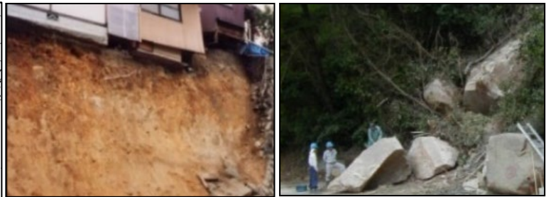
被害写真(気象庁現地調査資料より)
