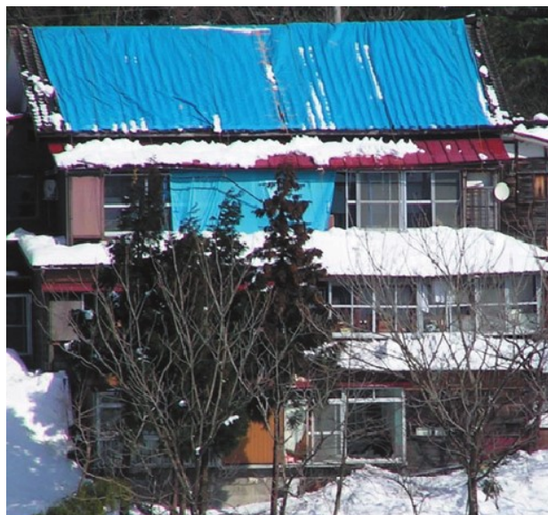
図2 屋根からの落雪で死亡事故が起きた旅館
