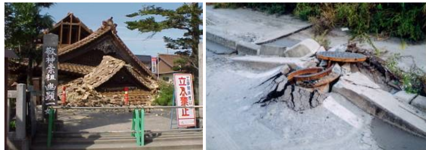
出雲大社上道教会の南側半分が倒壊 液状化による地盤の歪みによりマンホールの枠が半分に割れた
