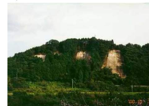
山腹崩壊 (旧岸本町 震度6弱) ・家屋等：半壊10棟、一部破損1,097棟
