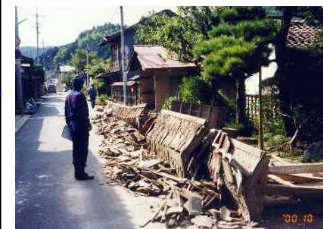
民家外壁の倒壊
