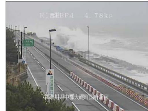
国道1号西湘バイパスの越波状況(神奈川県大磯町)
