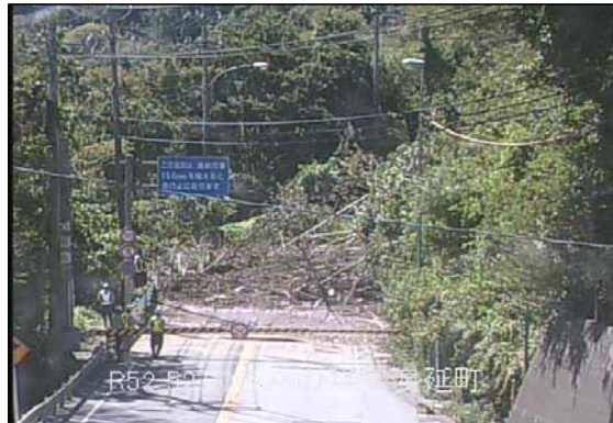
国道52号土砂崩落(山梨県身延町)
