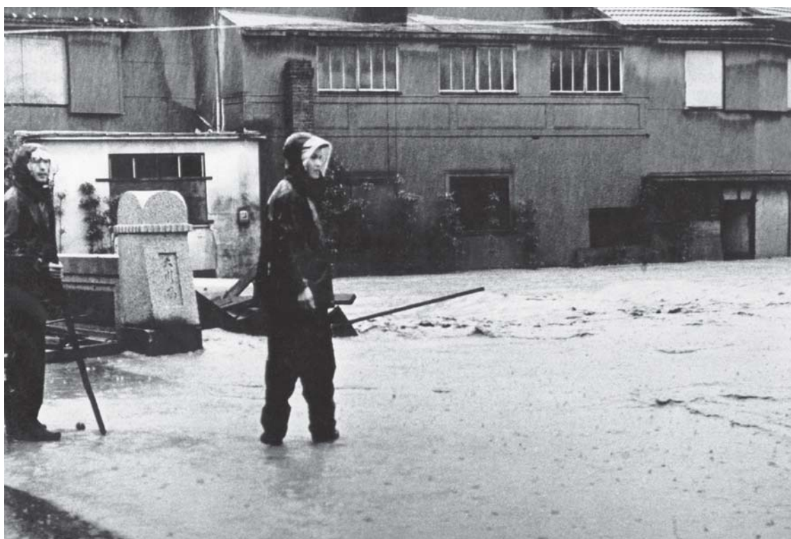
安田大川の氾濫（大川橋）
