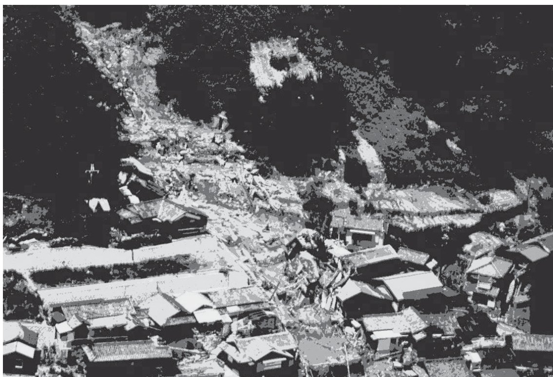
橘地区土砂崩れ
