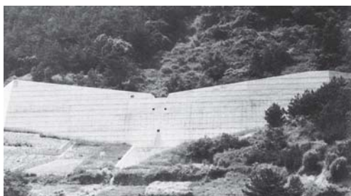
吉ヶ浦川（昭和53年11月完成）
