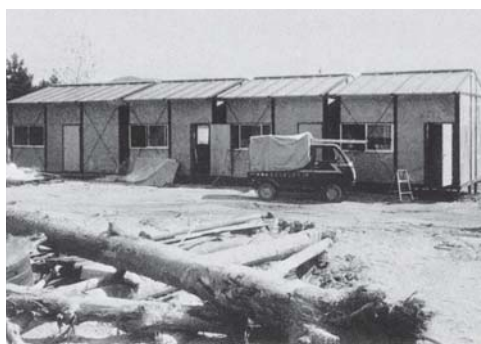
西村地区竹生に建築中の仮設住宅
