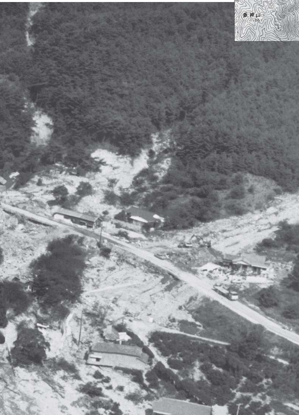
室生地区赤坂の土砂崩れ
