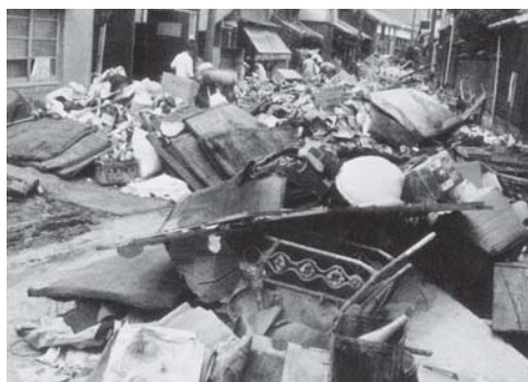
道路上にはき出されたゴミの山
