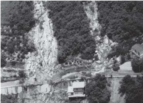
岩谷地区の土砂崩れ
