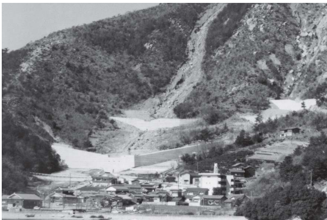
二面地区（石場） 上からの落石や大量の土砂にも耐えられるよう、谷に数か所の砂防ダムが造られた。
