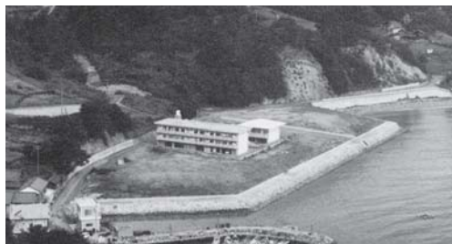
谷尻地区の埋立て（昭和53年3月31日完成）
