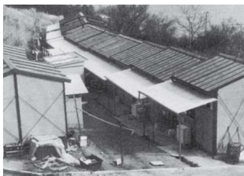
建設された仮設住宅
