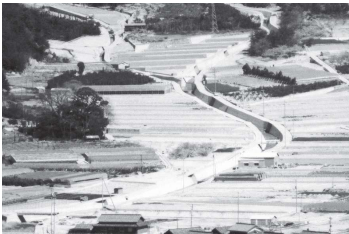
池田地区（上地） 土石流により、山の土や岩石に覆われていた農地は数年かけてそれらが取り除かれ、ビニールハウスも再建された。復旧した農地の面積は 10.03 ヘクタール、昭和 54 年 2 月に完成した。
