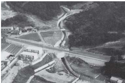
竹生川（昭和53年3月30日完成）
