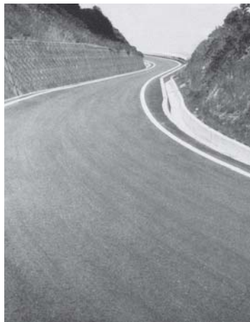
谷尻白浜線 （昭和53年 3月30日完成）
