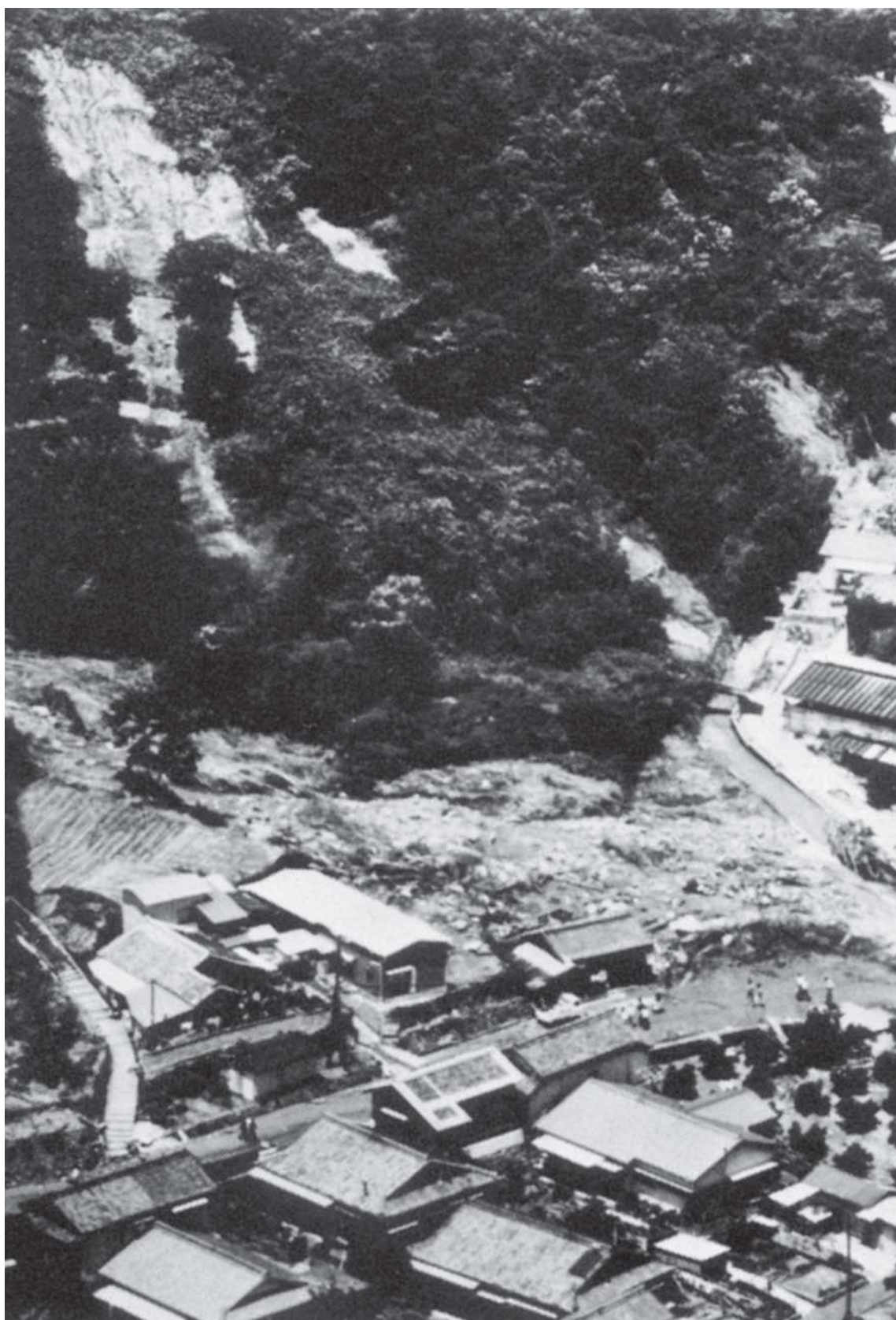
橘地区の土砂崩れ
