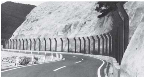
県道蒲野内海線（現県道蒲野西村線）（蒲野） （昭和53年8月25日完成）
