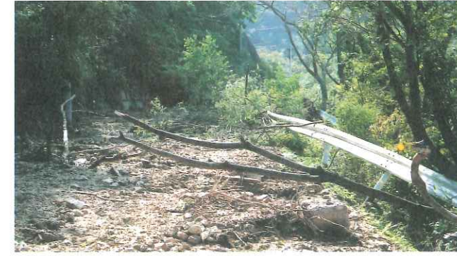
土砂崩れで県道津田川島線が通行不能(田面地区)
