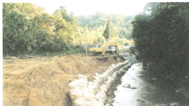
爛川護岸の復旧作業(南川地区)
