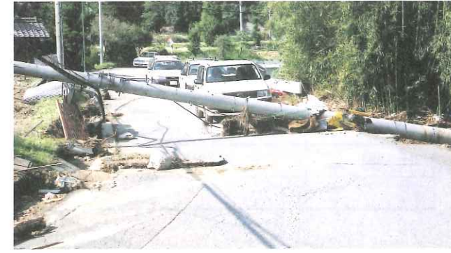
市道南川線に電柱が倒れ通行不能(南川地区)
