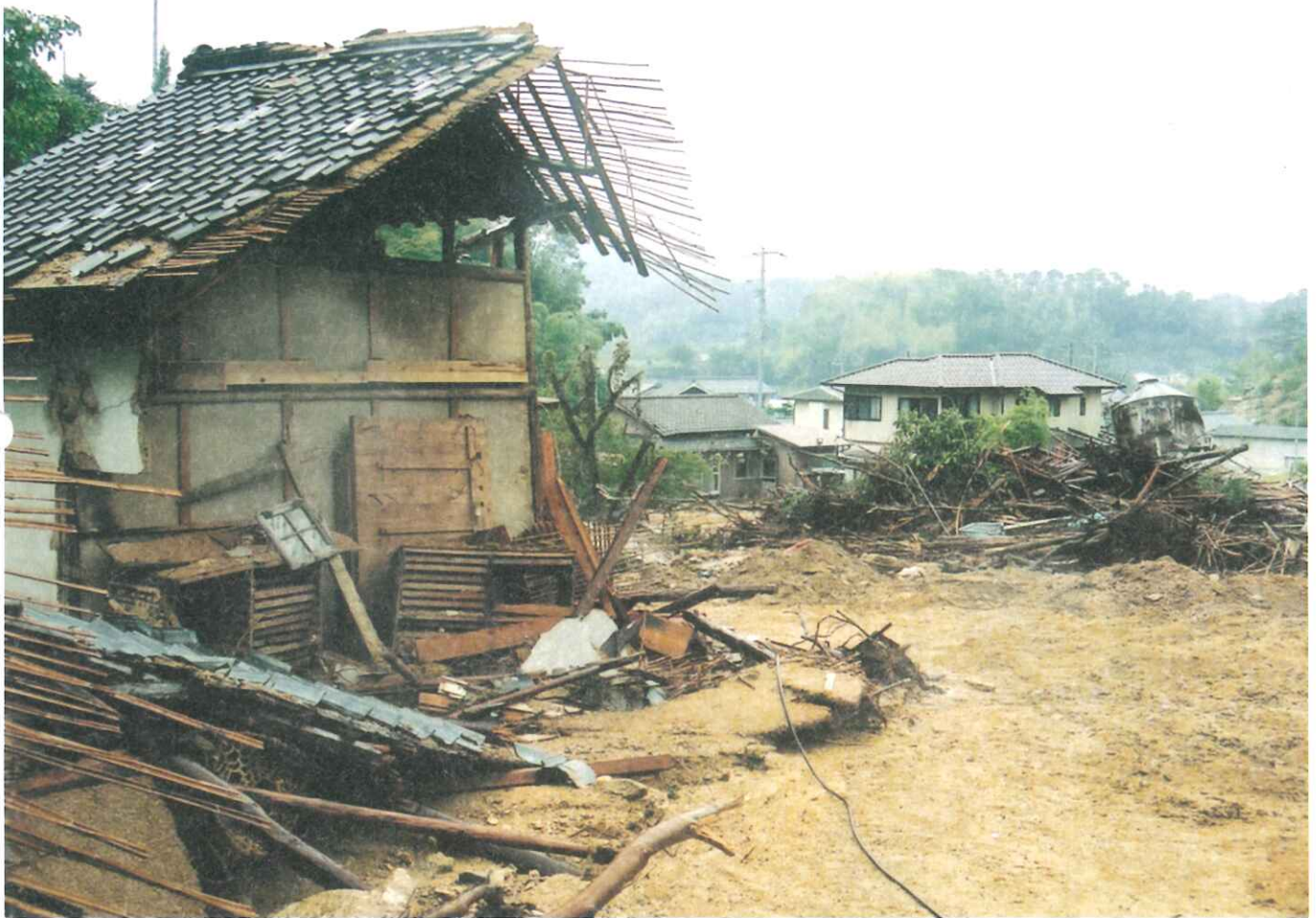
突然襲って来た土石流で建物が全壊（田面地区）
