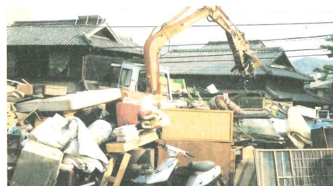
粗大ゴミの撤去作業(志度地区)
