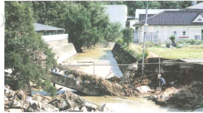
崩れ落ちた弁天橋(田面地区)
