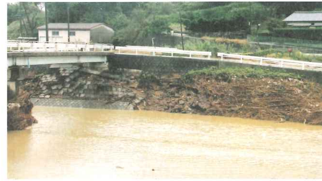
津田川の護岸ブロックが流失(津田地区)
