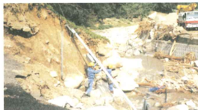
門入地区でのCATV柱の復旧作業(石田地区)
