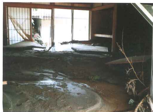
建物内部にはたくさんの土砂が流れ込んだ(笠松地区)
