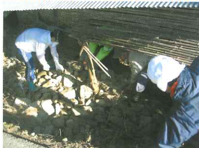
土石を手作業で除去(小海地区)
