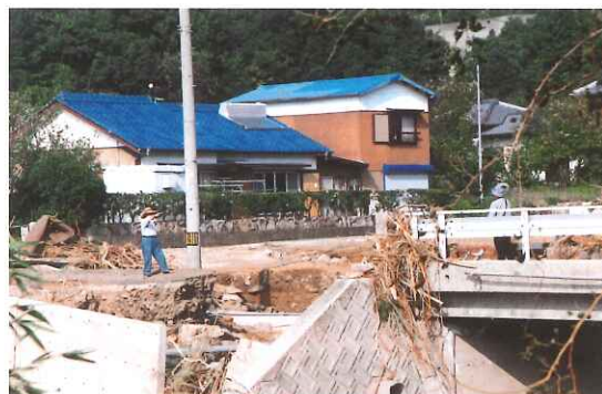
災害見舞いに訪れた人と陥没した道路を挟んで (森兼地区)
