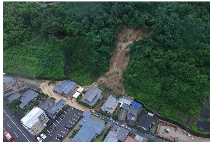
屋島西町で発生したがけ崩れ (香川県提供)
