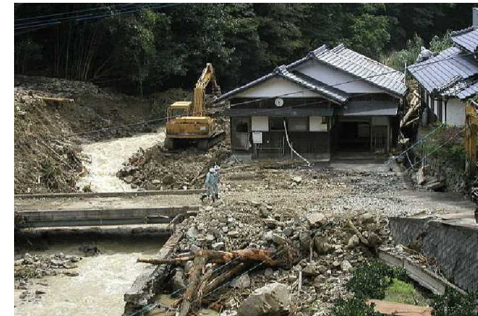
土石流被害：大野原町 (高松地方気象台撮影)
