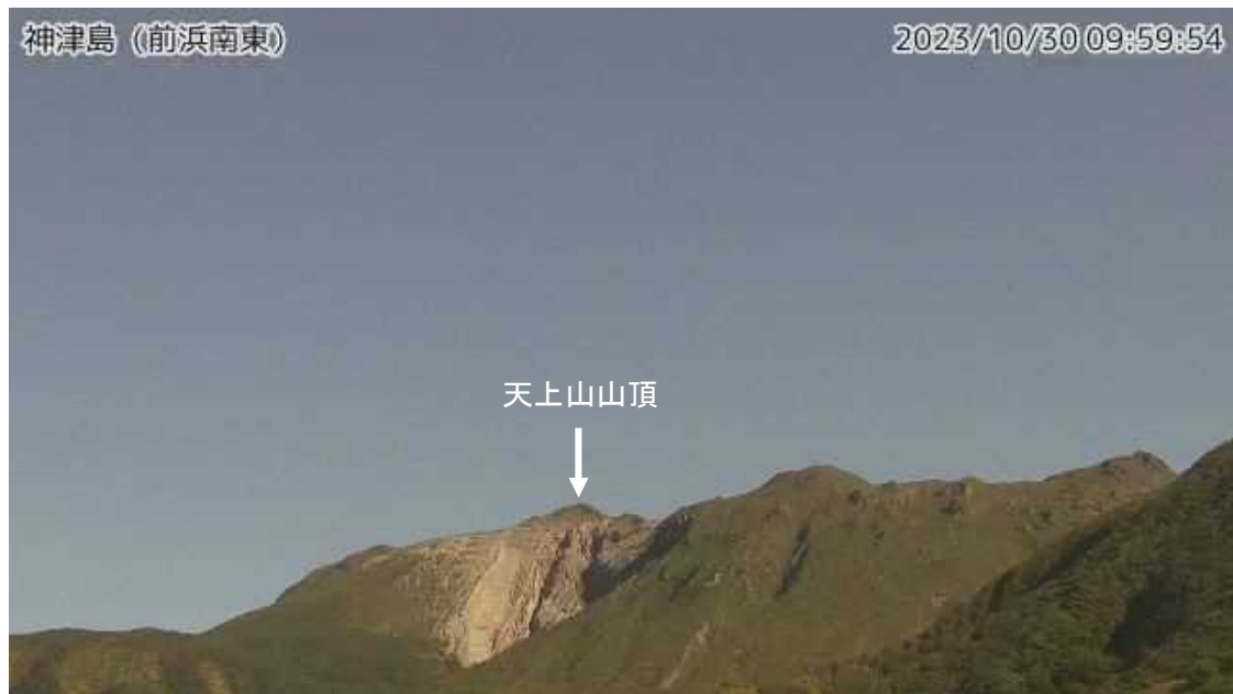
図1 神津島 天上山山頂部の状況 (10月30日、前浜南東監視カメラによる)
