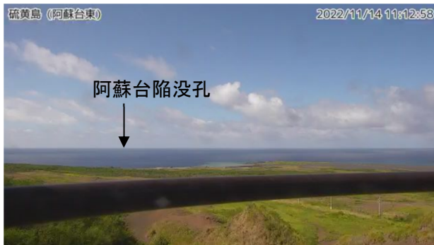
阿蘇台陥没孔の噴気の状態(11月14日撮影)
