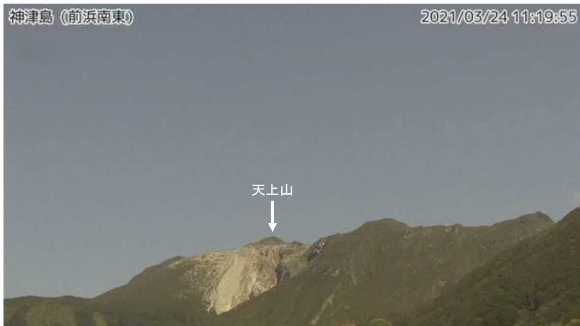
図1 神津島 天上山山頂部の状況 （3月24日、前浜南東監視カメラによる）
