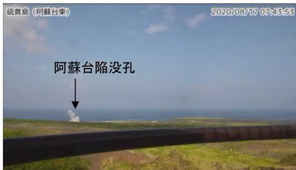
阿蘇台陥没孔の噴気の状況（8月17日撮影）
