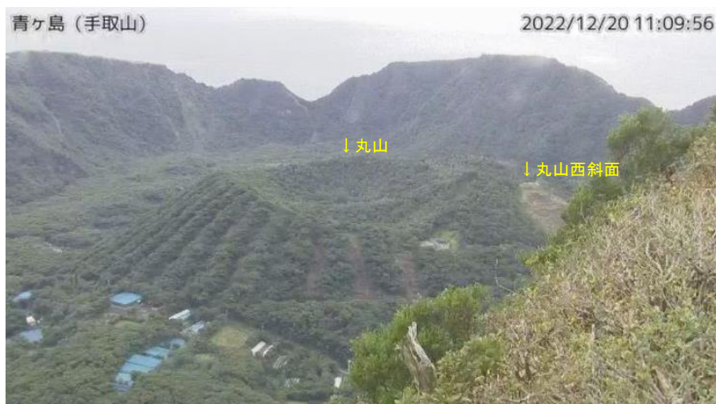
図1 青ヶ島 丸山西斜面の状況（12月20日、手取山監視カメラによる）
