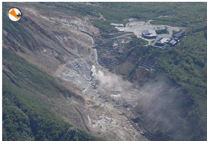
2015 年 5 月 13 日 14 時 22 分 関東地方整備局の協力により撮影
