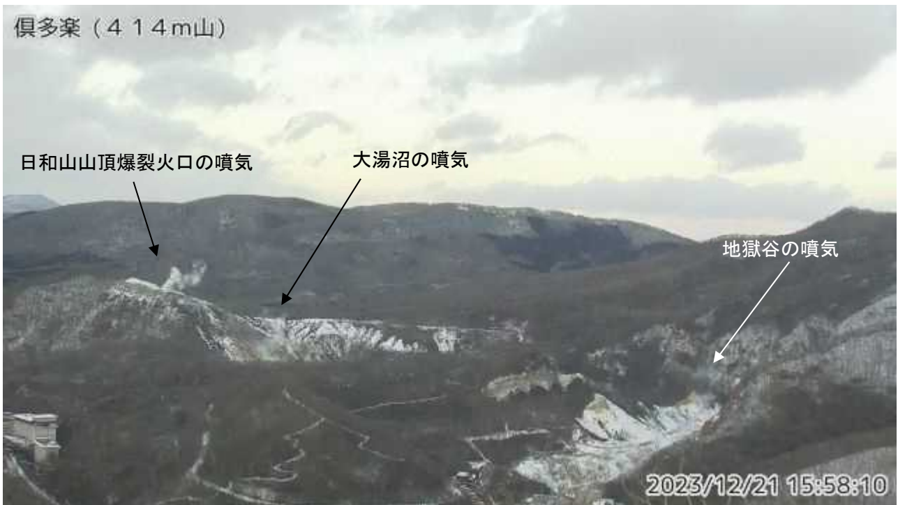
図1 倶多楽 南西側から見た日火山、大湯沼及び地獄谷周辺の状況（414m山監視カメラによる）
