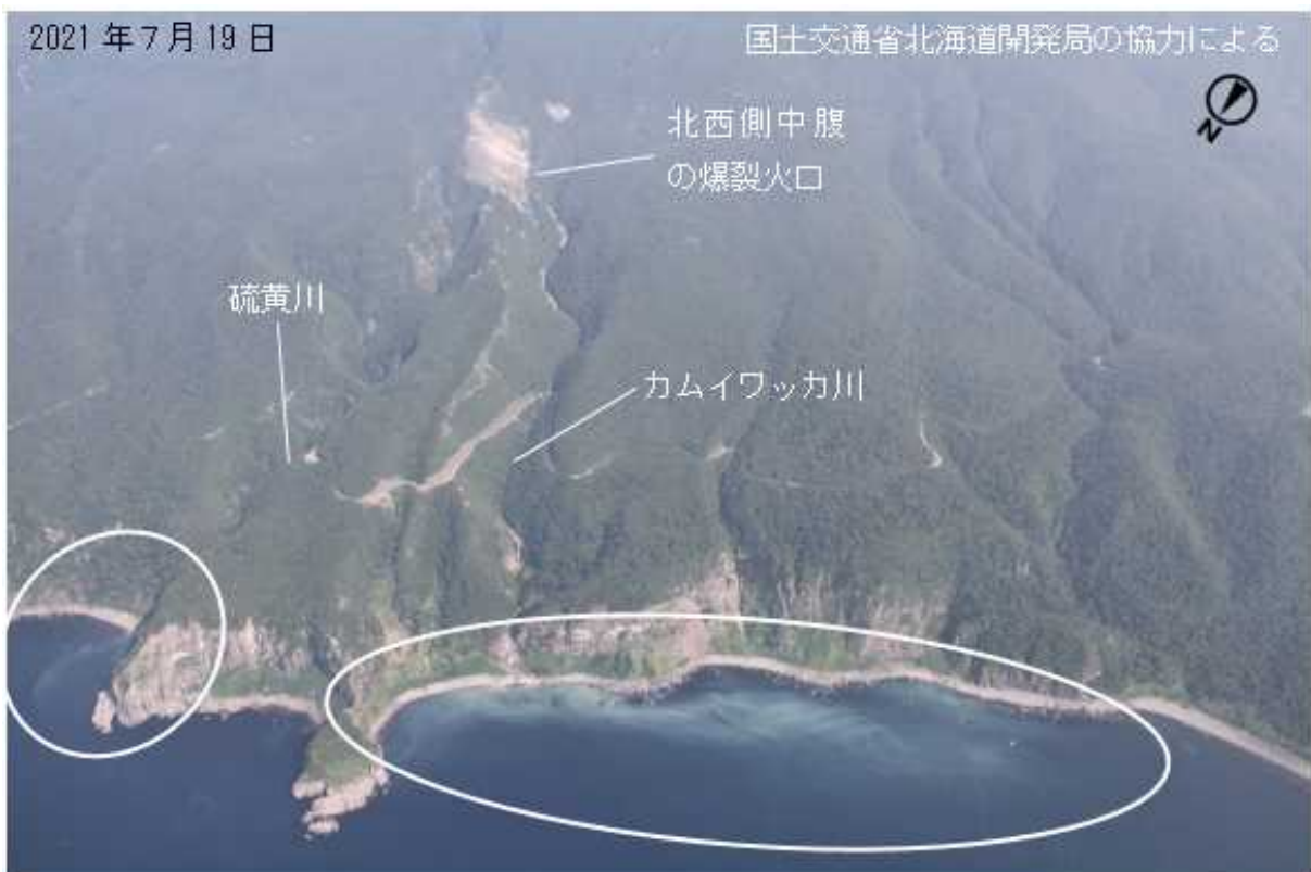
図3 知床硫黄山 硫黄川及びカムイワッカ川の河口付近の状況 北西側上空（図1の②）から撮影 ・前回の観測（2019年7月）と同様に、海岸付近では温泉水による変色域が認められました。
