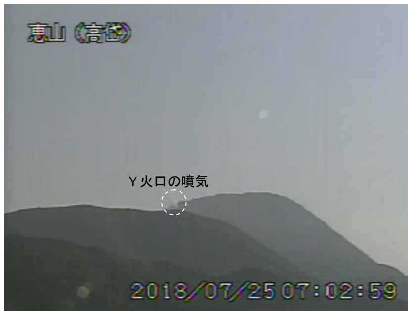
図1 恵山 西南西側から見た山頂部の状況（7月25日、 ただい 高岱監視カメラによる）
