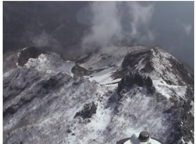
西頂側上空から見た山頂東側爆裂火口
