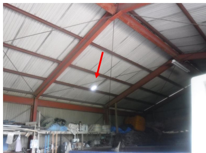
図 1-3 桜島 落下痕の近傍の建物で確認した屋根の被害状況及びその被害をもたらした岩石（写真提供：鹿児島市）
