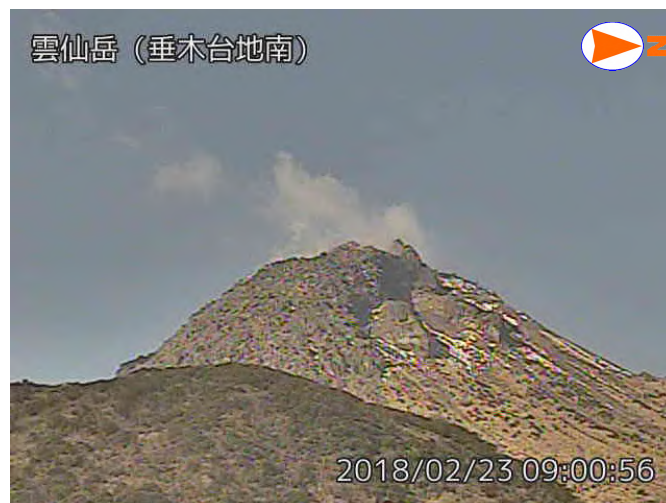
図 1 雲仙岳 平成新山の状況（2 月 23 日、垂木台地南監視カメラによる）
