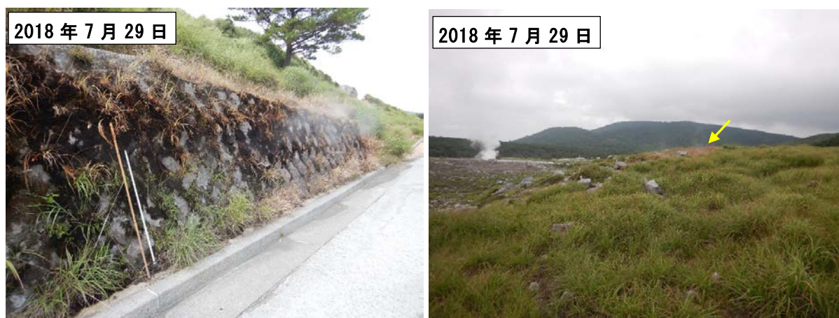
第5図 不動池南側の県道法面及びM8北側の噴気
