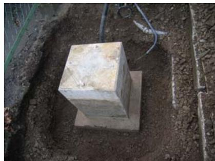
写真6 震度計台周囲開削終了後
