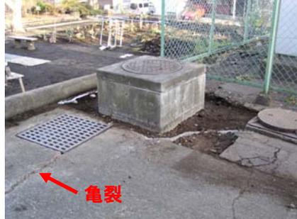
写真2 排水枡コンクリート部の亀裂
