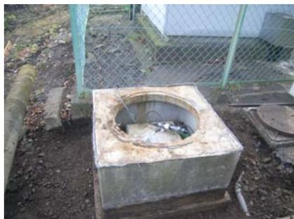
写真4 コンクリート枡の蓋撤去
