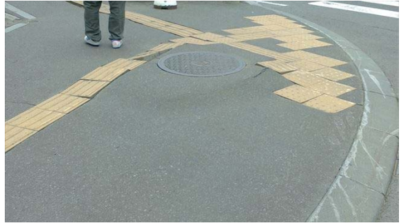
写真2 浮上したマンホール (札幌東区元町地区)
