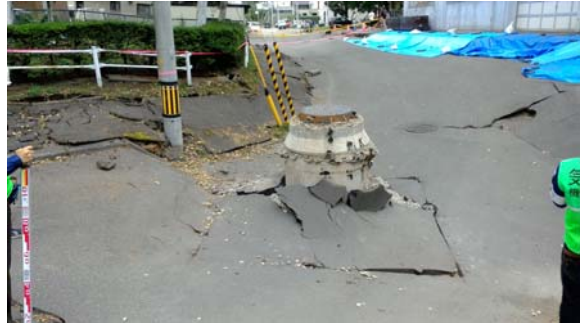
写真2 浮上したマンホール (札幌東区元町地区)
