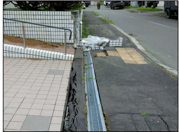
写真5 歩道の亀裂
