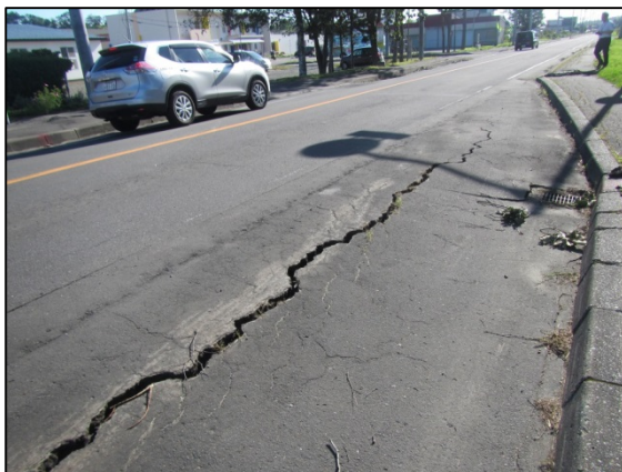
写真6 道路の亀裂
