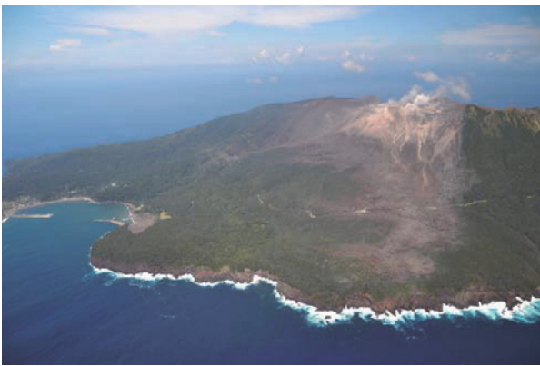
図 3 口永良部島 新岳の西から南西側の状況 九州地方整備局災害対策ヘリコプターはるかぜから撮影 6日14時37分 新岳の南西から西にかけての山腹から山麓にかけて、火山灰や火山ガスによる樹木の変色を確認した。
