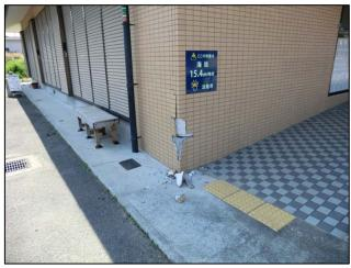
写真 5 淡路市多賀(図 7 - 2) 集会所外壁剥離
