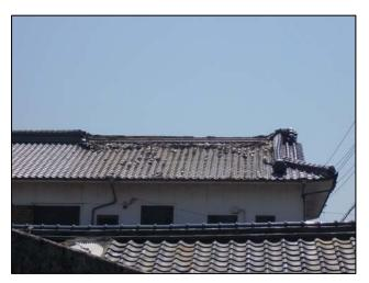
写真 11 南あわじ市松帆古津路 (図 7 - 3) 屋根瓦落下
