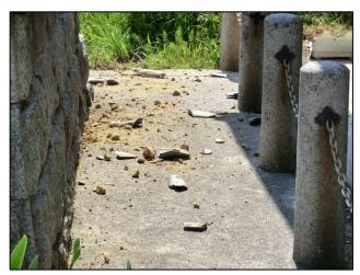
写真 6 淡路市多賀(図7-2) 集会所屋根瓦落下
