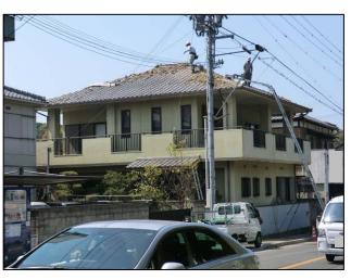
写真4 淡路市多賀(図7-2) 屋根瓦剥離
