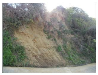
写真 14 洲本市五色町鳥飼浦(図7-3) 船瀬漁港に入る道路脇崖崩れ (幅約8m、高さ約7m)
