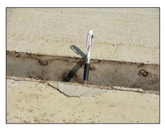
写真3 淡路市生穂:生穂漁港(図7-2) 陥没10センチ
