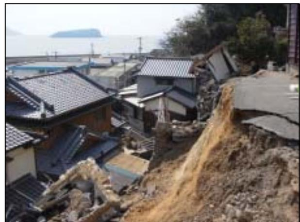
写真 7 がけ崩れにより損壊した道路
