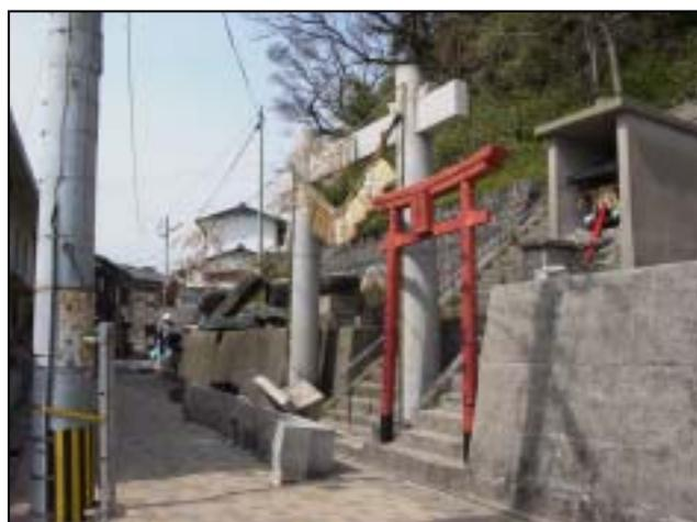
写真1 鳥居上部の落下, 灯籠の倒壊
