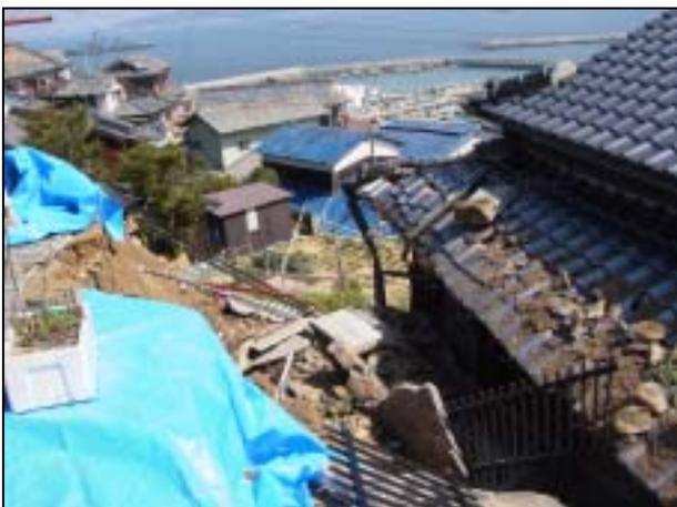
写真 6 がけ崩れにより損壊した家屋
