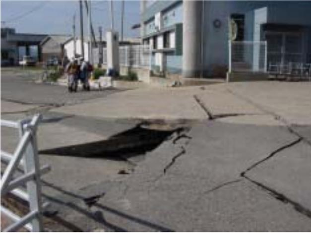
写真 3 岸壁の亀裂，陥没
