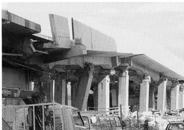
写真17. JR東海道本線 橋脚、橋桁全壊
