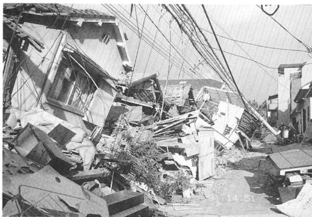
写真34. 家屋の倒壊 (神戸市灘区北部)
