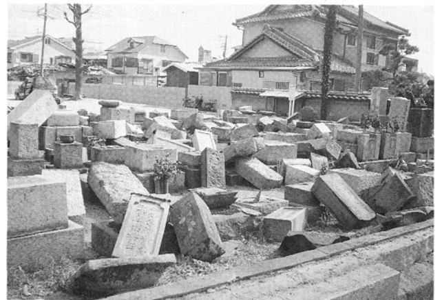
写真42. 墓石の転倒(極楽寺) 墓石の落下方向は、西側(写真手前)
