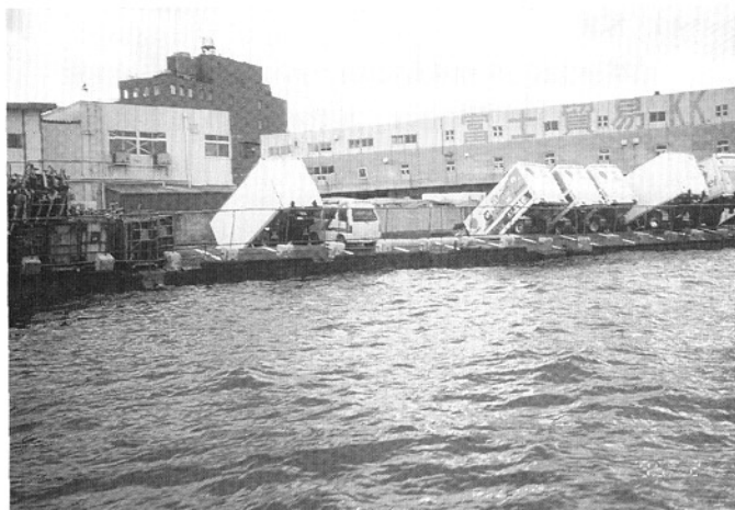
写真7．護岸内側が、約1～2m陥没 (神戸市東灘区深江浜町)
