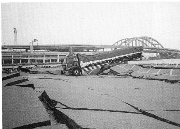
写真8．液状化による陥没で動けなくなったトラック (神戸新港第3突堤先端)
