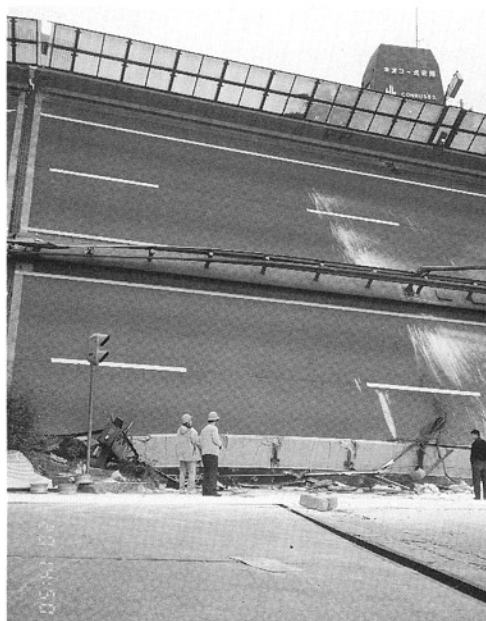
写真20. 阪神高速道路の倒壊
