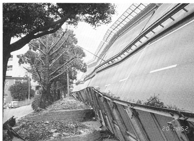
写真22. 阪神高速道路の倒壊
