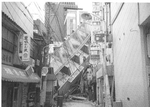
写真36. 家屋の倒壊(飲食店街) (中山手通り一丁目)
