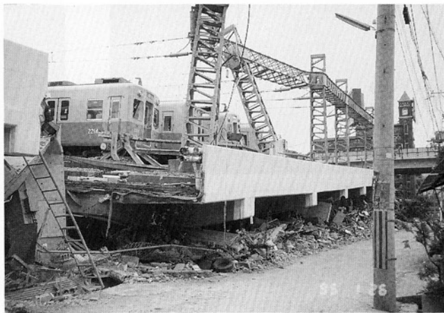
写真15. 阪神車両基地(神戸市東灘区) (高架下部柱が座屈)
