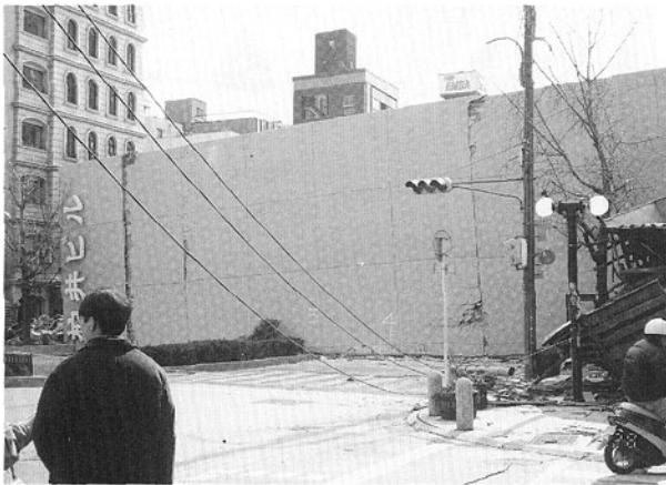
写真30. 三宮から新神戸への道をふさぐように倒れたビル
