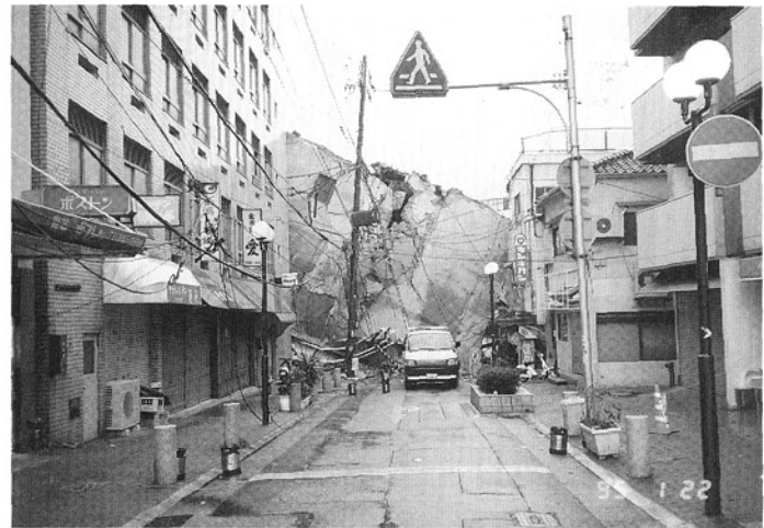
写真25. ビルの倒壊 (宝塚市山本東三丁目新池)
