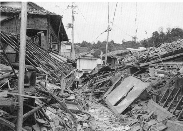
写真4．家屋の倒壊（北淡町富島）
