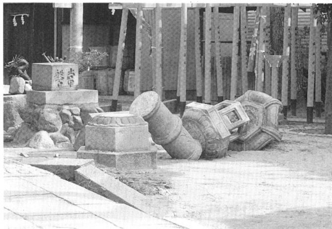
写真18. 魚崎八幡宮燈廊倒壊(南方向へ倒れる) (東灘区魚崎南町)
