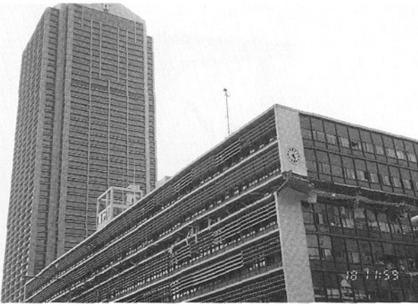
写真28. 神戸市役所(旧庁舎6階部分が圧壊)
