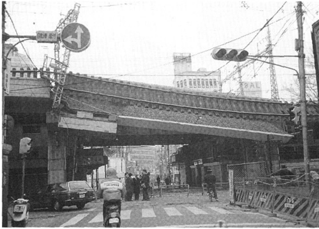
写真23. ガードが傾いて横になっている (山陽電気鉄道 三宮駅の西)
