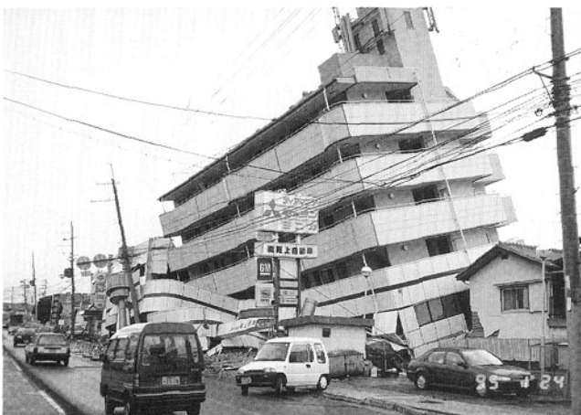
写真32. ビルの倒壊 (宝塚市山本中二丁目)
