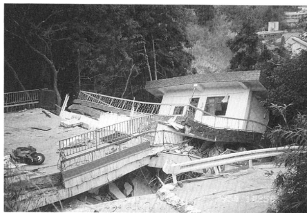
写真35. 家屋の倒壊 (神戸市北区有馬温泉)
