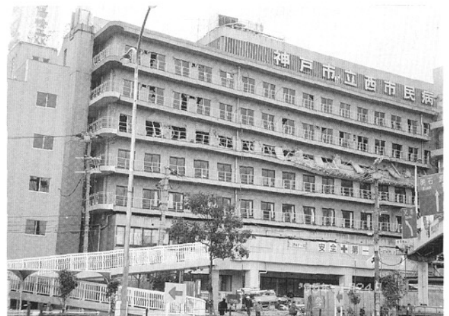
写真33. 神戸市西市民病院(長田区東) 5階部分が潰れている
