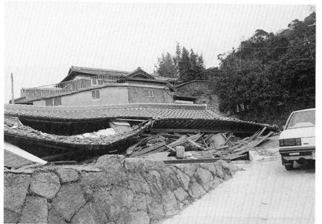
写真5．木造家屋の全壊（北淡町轟木）
