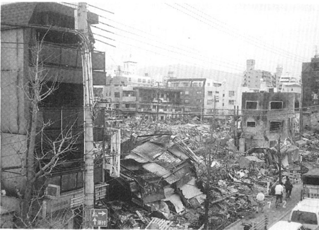
写真41. 六甲口琵琶町歩道橋北側の火災あと (神戸市東灘区)
